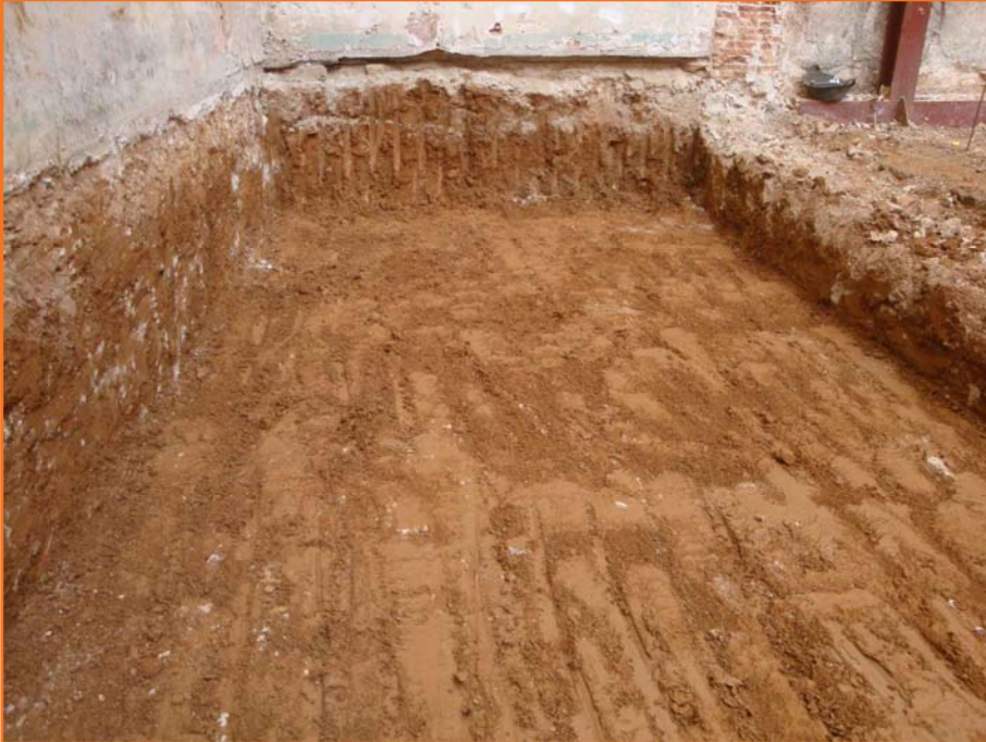
Foto 3. Vista del sector sud-oest del solar un cop realitzats els rebaixos.
