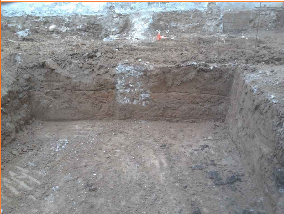
Foto 8. Vista general del rebaix per la sabata de fonamentació de la grua, un cop finalitzat, afectant l'estrat UE01, les riostes UE02 i el substrat geològic UE04.
