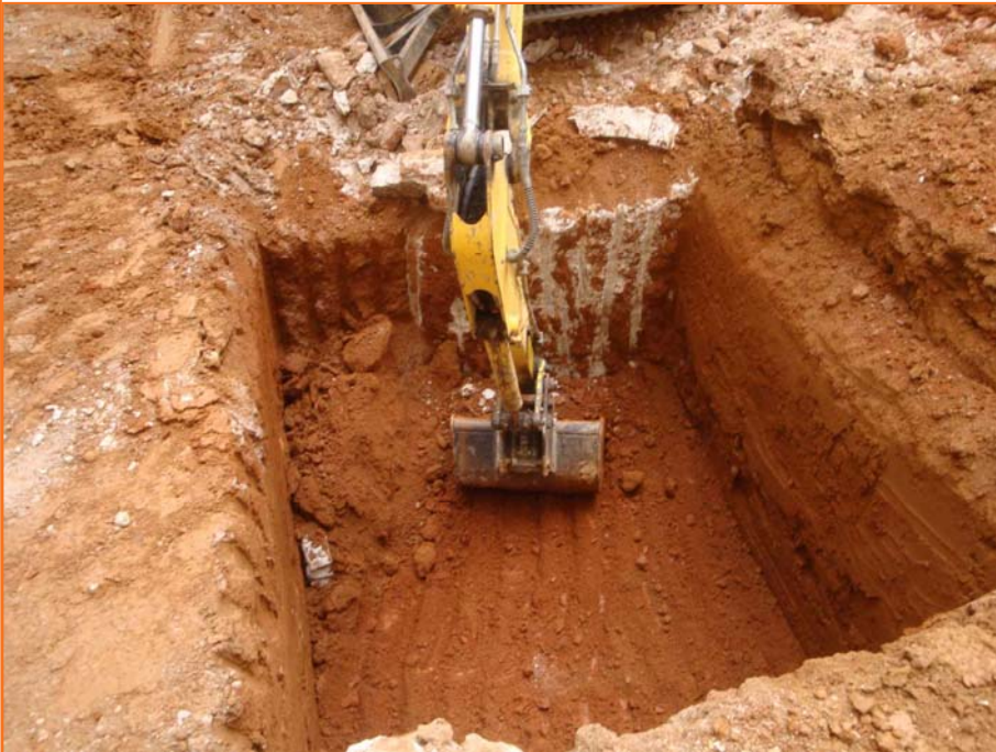
Foto 9. Vista general del procés de rebaix per ubicar el dipòsit d'aigües brutes de l'obra, situat a l'interior d'una crugia de riostes (UE02), afectant l'estrat UE01 i el substrat geològic UE04.
