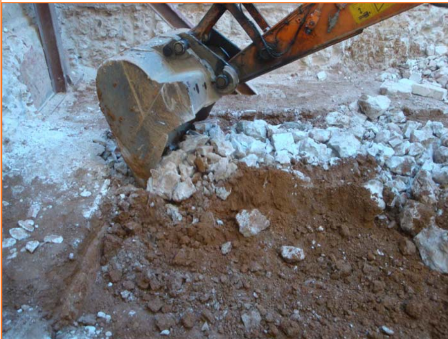
Foto 11. Procés d'obertura del fossat d'ascensor del cantó més proper a Ronda Sant Pere 28-30.
