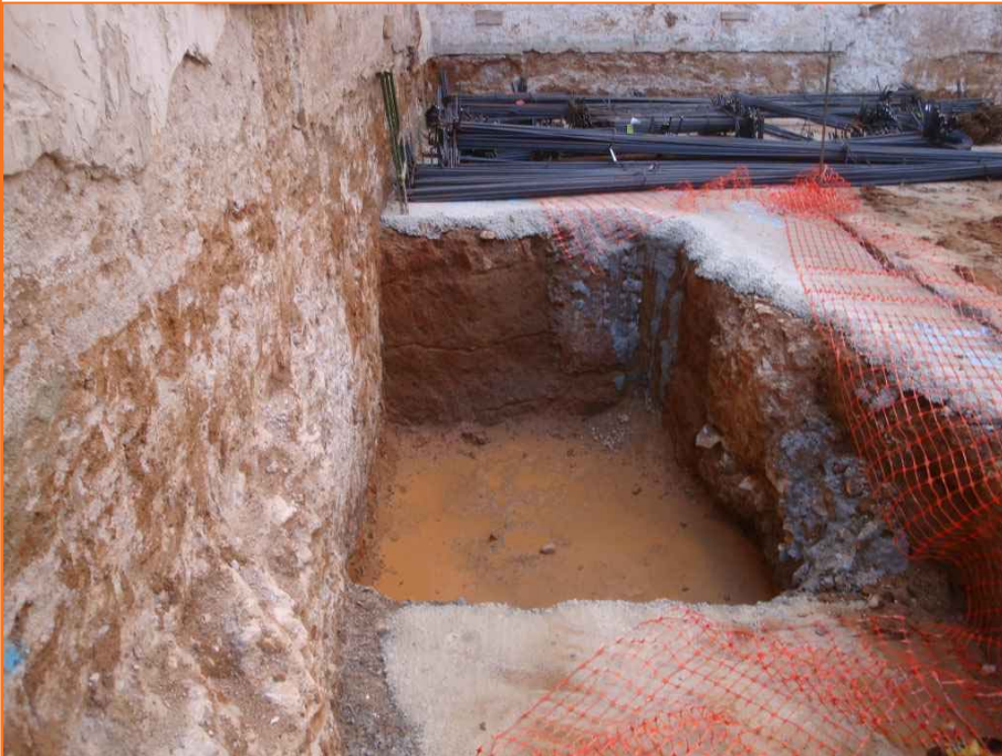
Foto 15. Vista general del rebaix d'un pou de cimentació, un cop finalitzat, afectant l'estrat UE01, les rústes UE02 i el substrat geològic UE04.
