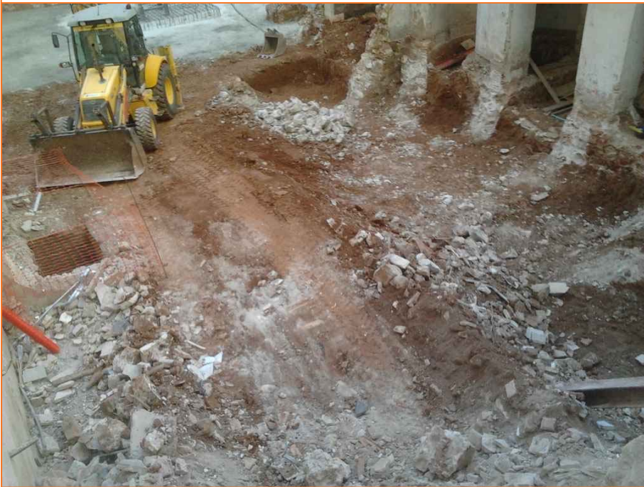
Foto 4. Procés d'excavació de les argiles UE01, en paral·lel al desmunt de les rústes UE02.
