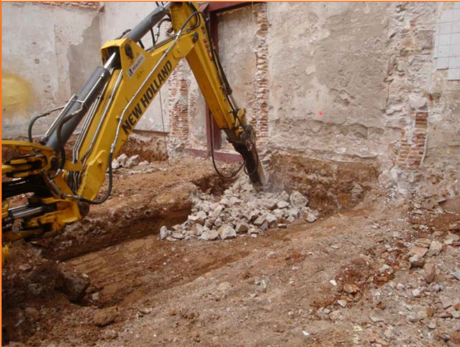
Foto 7. Vista del procés de desmunt de les riostes de l'edifici (UE02).
