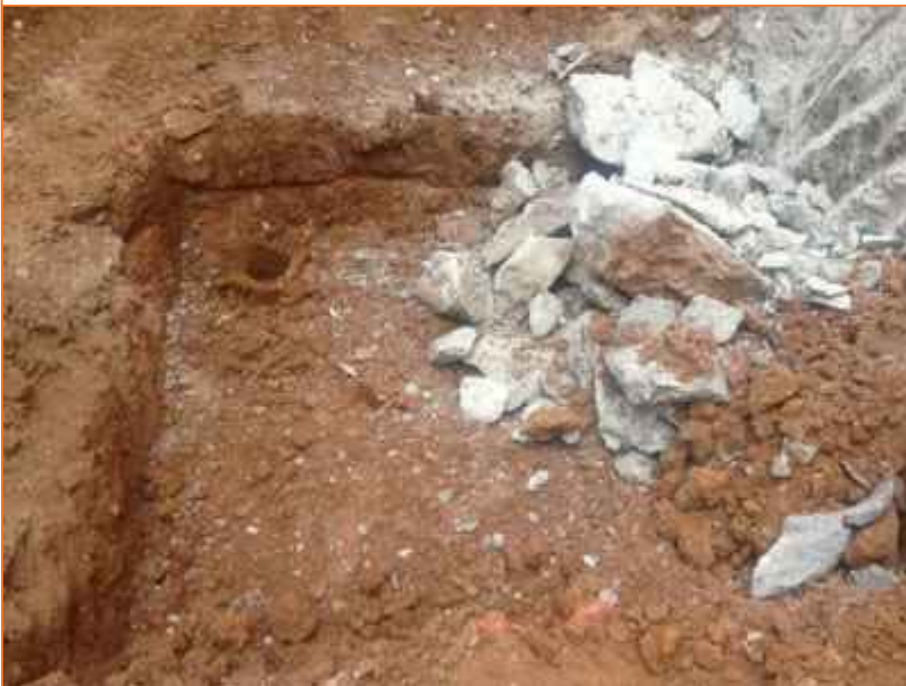
Foto 10. Vista del rebaix del fossat d'ascensor del cantó més proper a Ronda Sant Pere 34, amb la capa d'argiles UE01 i el substrat geològic UE04.
